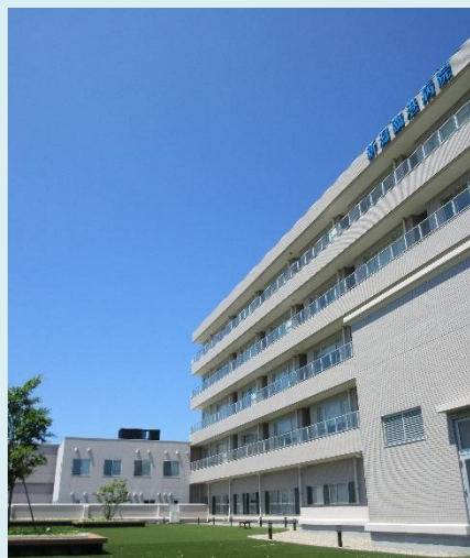
屋上庭園から見た外観📷
